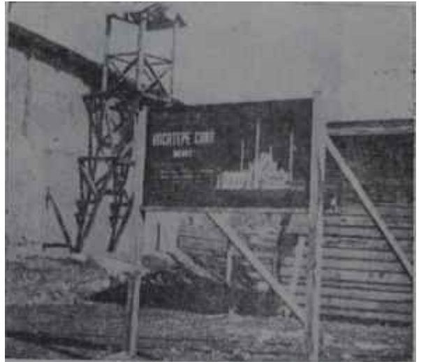
KOCATEPE CAMİİNİN İNŞAATI
