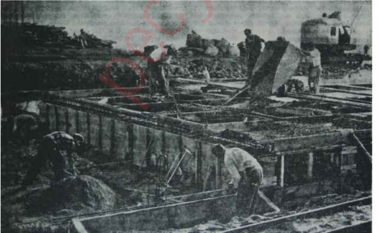
Yatırım faaliyetinin başlayacağı inşaat sahaları Dipsiz, kilerin dolu ambarları
