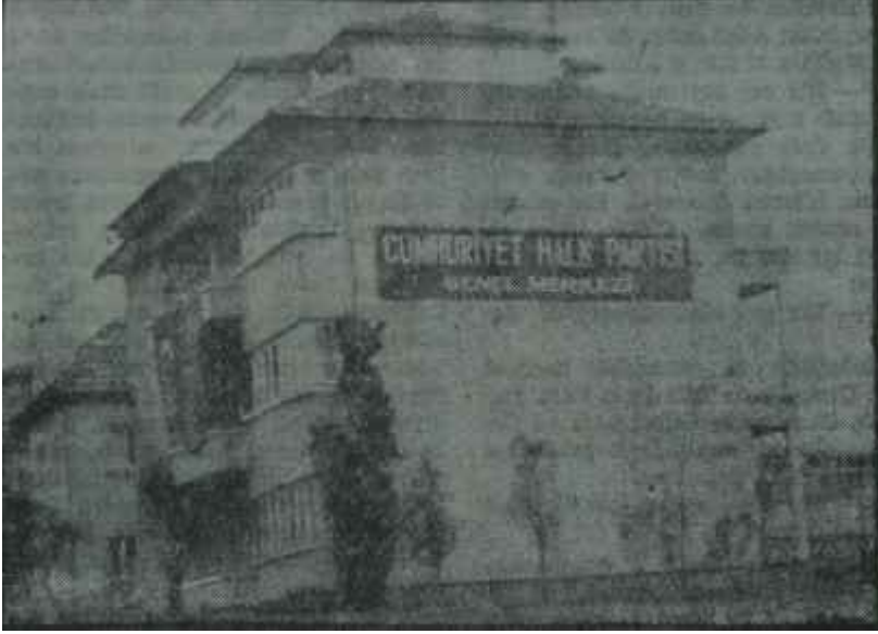
C. H. P. Genel Merkez binası
