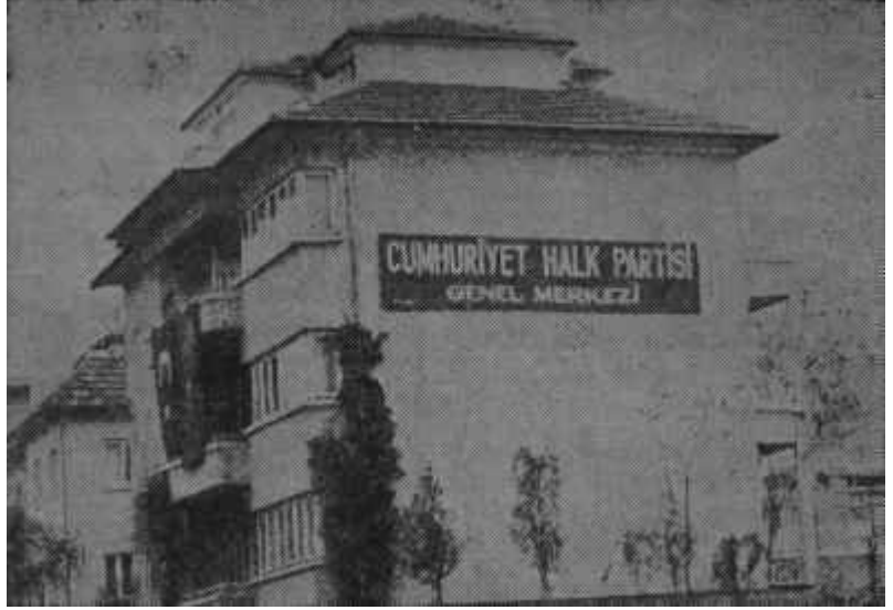
C.H.P. nin Karanfil sokaktaki Genel Merkez binası
