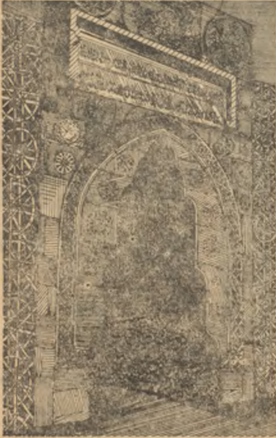
Kayseridaki Şifaiyenin Giriş Kapsı
