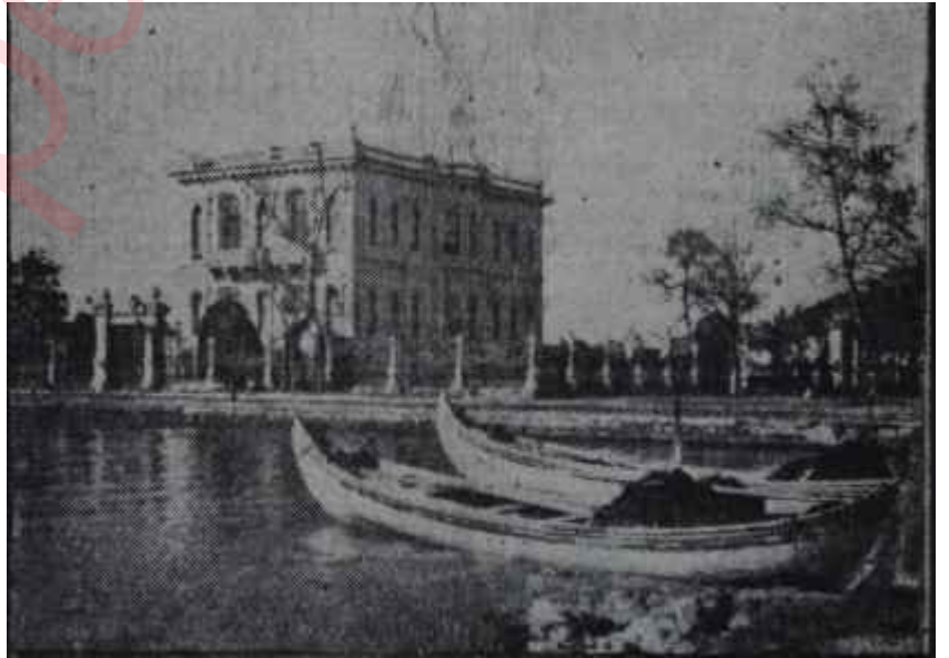
Küçüksu kasrının görünüşü Vapur dumanı dokunuyor
